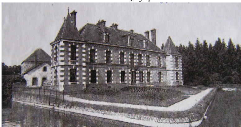
La Brenellerie côté douve, façade est
